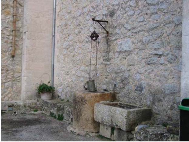
La cisterna i l'abeurador que es recolzen a la façana lateral de l'església
