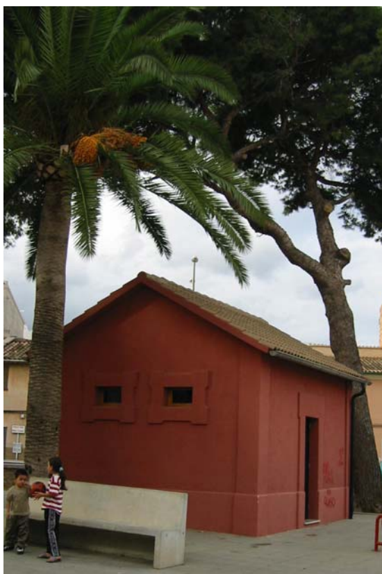
Edifici annex de banys.
